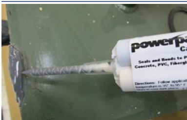
Applicare PowerPatch sulla toppa di stucco o sull'area della perdita
