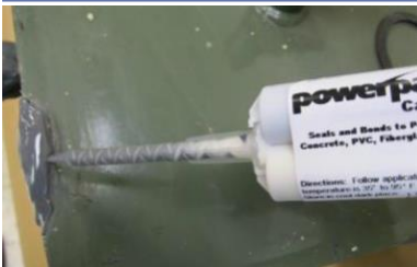
Aplique PowerPatch sobre el parche de masilla o el área con la fuga
