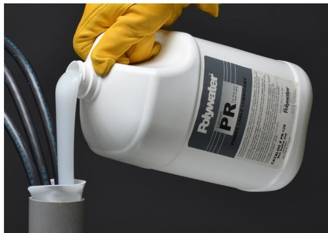
Le lubrifiant Polywater PR est versé dans une montée de conduits.
