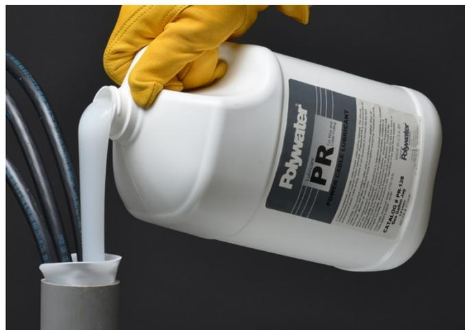
*Polywater PR wird in ein Rohr gegossen*
