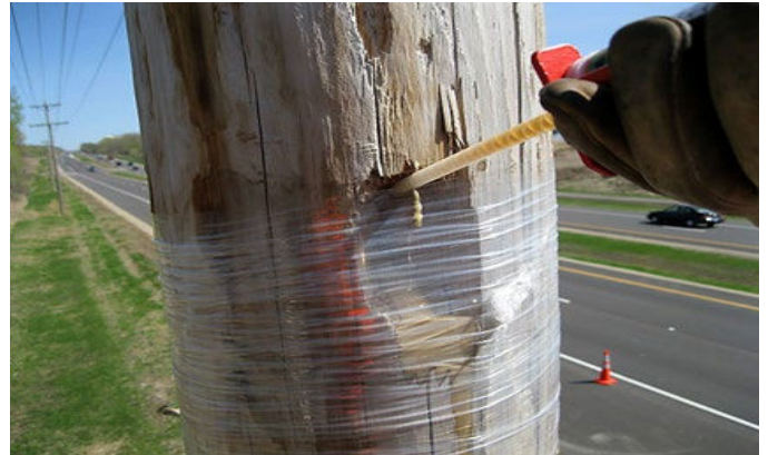
Il prodotto Polywater UPR PR Pole Repair può essere applicato senza praticare fori aggiuntivi nel palo.
