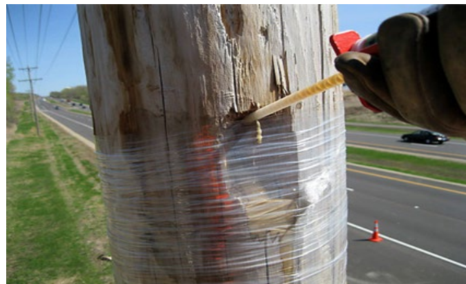
Le produit de réparation de poteaux Polywater UPR PR peut être appliqué sans percer de trous supplémentaires dans le poteau.
