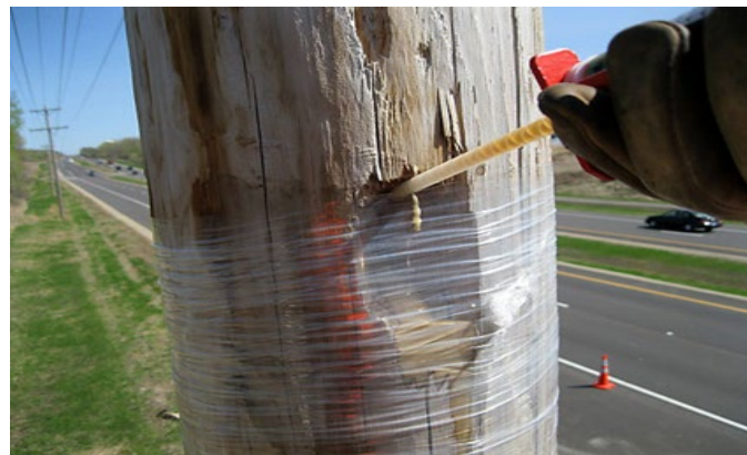
Polywater UPR PR Pole Repair puede aplicarse sin taladrar orificios adicionales en el poste.
