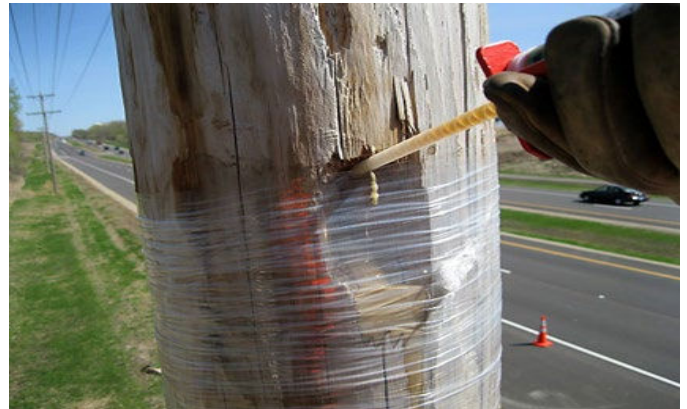
Il prodotto Polywater UPR NF Pole Repair può essere applicato senza praticare fori aggiuntivi nel palo.
