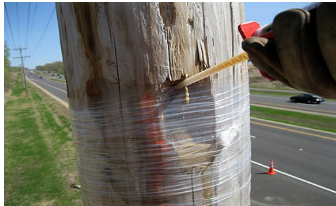
Le produit de réparation de poteaux Polywater UPR NF peut être appliqué sans percer de trous supplémentaires dans le poteau.
