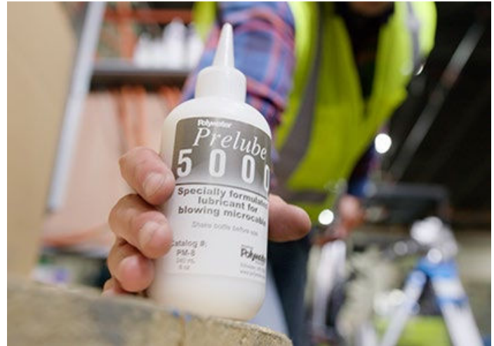
Prelube 5000 applicato al condotto prima di soffiare il cavo in fibra
