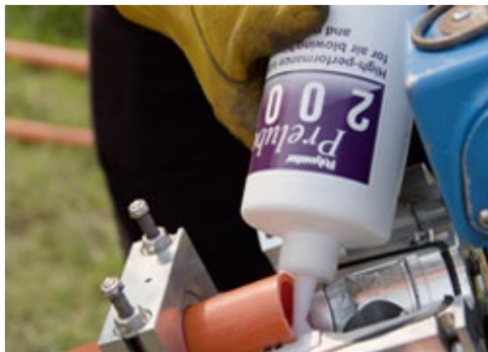
Prelube 2000 aplicado al ducto antes de soplar el cable de fibra
