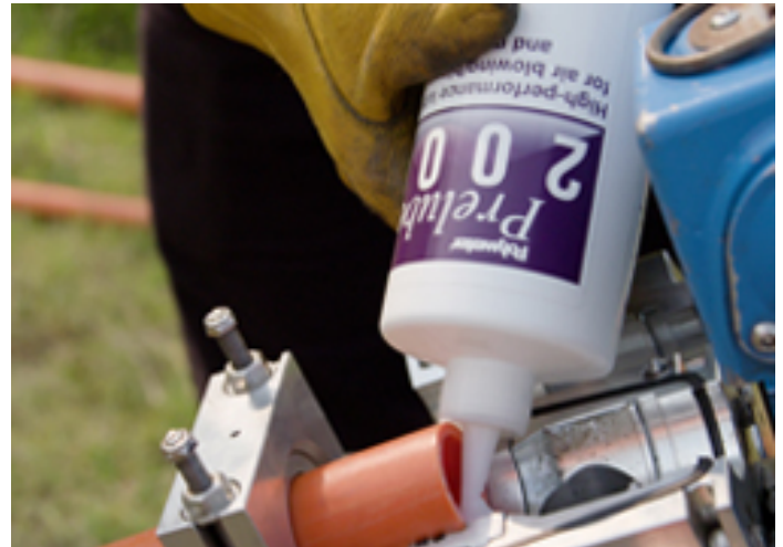
Prelube 2000 wird vor dem Einblasen eines Glasfaserkabels in das Rohr gedrückt
