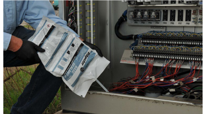
PedFloor repara y crea una barrera para las bases del gabinete.
