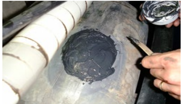
Il sistema di riparazione delle perdite AirRepair sigilla le perdite d'aria nei cavi pressurizzati e nelle giunzioni.
