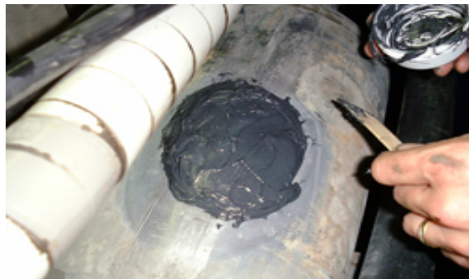
El sistema de reparación de filtraciones AirRepair sella las filtraciones de aire en cables y empalmes presurizados.
