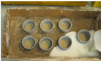
InstaGrout viene miscelato e versato
