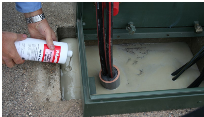
InstaGrout répare et crée une barrière protectrice pour les socles de baies.
