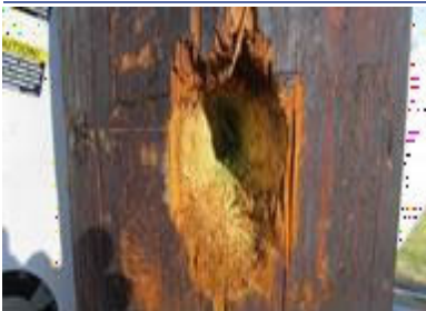
Retirer tous les débris et l'eau du trou
