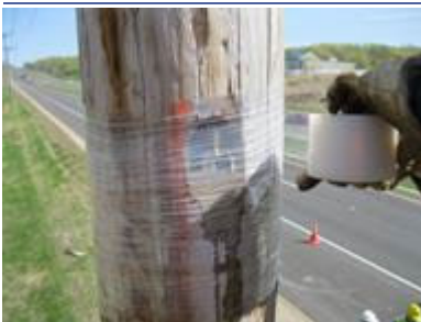
Recouvrir le trou de film étirable
