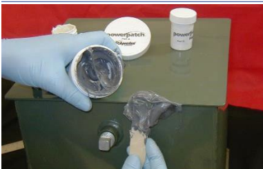
Appliquer PowerPatch par-dessus le patch de mastic ou la zone de fuite.
