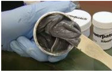
Mélanger les deux pâtes du produit d'étanchéité jusqu'à obtenir un gris uniforme.
