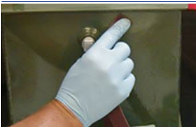
Poncer ou brosser la zone de réparation
