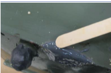
Lisser les bords de PowerPatch
