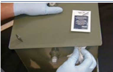
Nettoyer la zone avec une lingette nettoyante avant d'appliquer le produit d'étanchéité.
