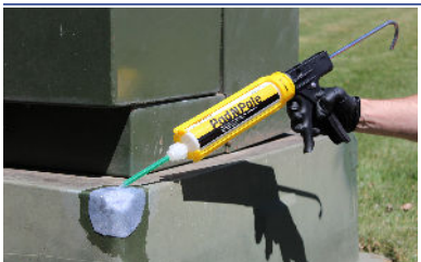
Recouvrir le matériau textile de Pad N Pole
