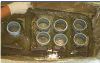
Étaler InstaGrout à l'aide d'un bâton
