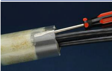
Utiliser un tournevis pour vérifier l'absence de vides.
