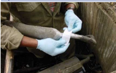
Nettoyage du câble avec une lingette nettoyante
