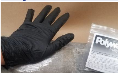
Maintien du mastic lors du séchage
