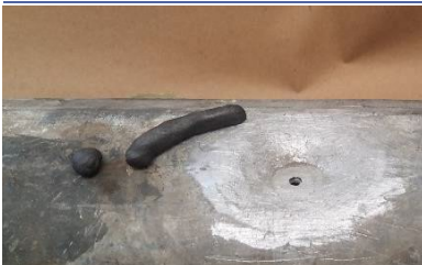
Roulage du mastic
