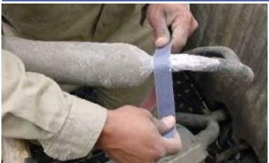
Ponçage du câble pour la réparation
