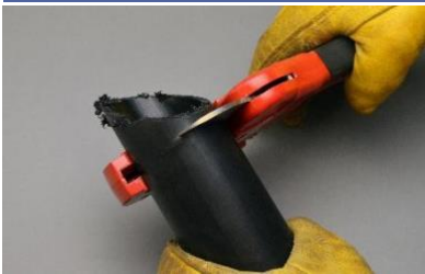
Cortar el extremo del conducto en un ángulo recto
