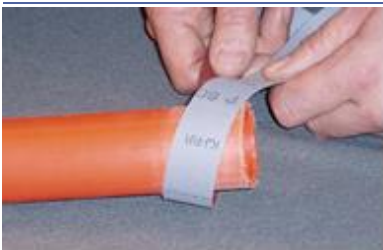
Lije el conducto y el acoplamiento
