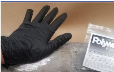
Sostener la masilla durante el fraguado
