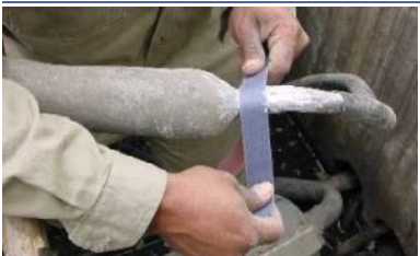
Lijando un cable para su reparación
