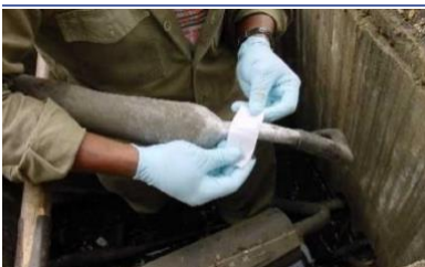
Limpieza del cable con un paño limpio
