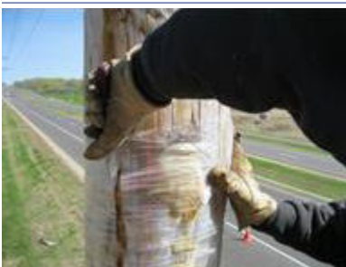
Zugangsöffnung mit Umwickelfolie abdecken
