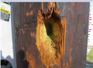
Alle Verschmutzungen und Wasser aus dem Loch entfernen
