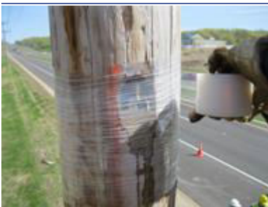
Loch mit Umwickelfolie bedecken
