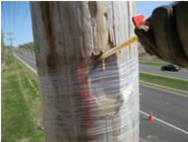
Statischen Mischer einsetzen und Material schnell in das Loch einspritzen
