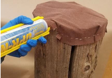
UPR-NF an der Oberkante des Mastes injizieren. Den statischen Mischer während des Einspritzens bewegen.
