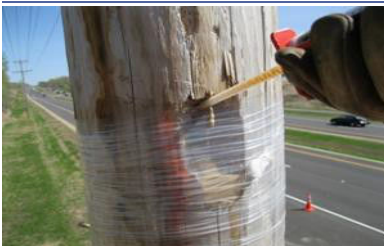
Statischen Mischer einsetzen und Material schnell in das Loch einspritzen
