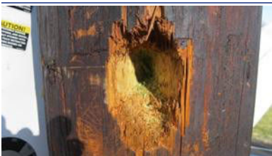
Alle Verschmutzungen und Wasser aus dem Loch entfernen
