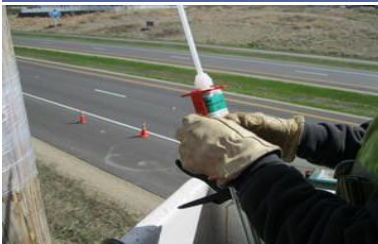
Kartusche in ein Abdichtungswerkzeug mit hohem Übersetzungsverhältnis einlegen
