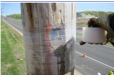
Loch mit Umwickelfolie bedecken
