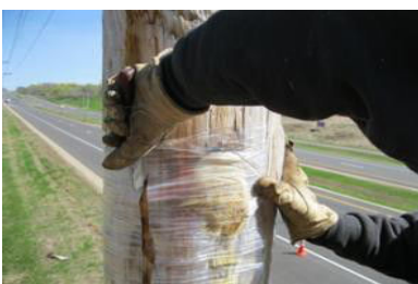
Zugangsöffnung mit Umwickelfolie abdecken
