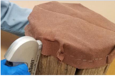
Plane am Mast befestigen.
