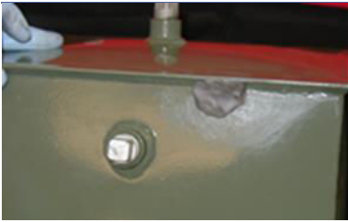
Polywater Spachtelstange auftragen
