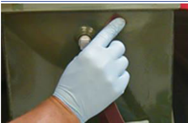
Den Reparaturbereich schleifen oder bürsten
