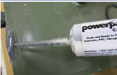
PowerPatch über Spachtelmasse-Patch oder der Leckstelle auftragen
