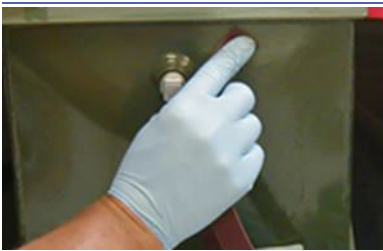
Den Reparaturbereich schleifen oder bürsten
