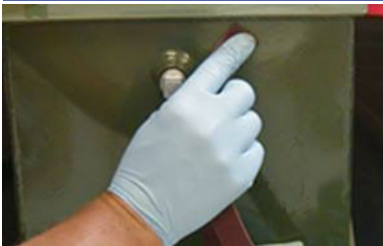
Den Reparaturbereich schleifen oder bürsten
