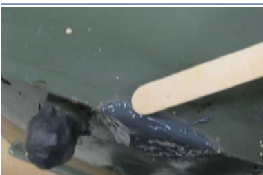
Kanten des PowerPatch glätten
