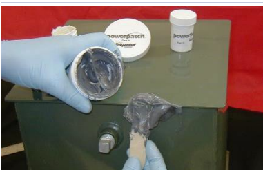
PowerPatch über Spachtelmasse-Patch oder der Leckstelle auftragen
