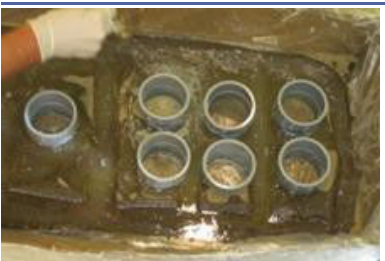
PedFloor mit einem Rührstab verteilen
