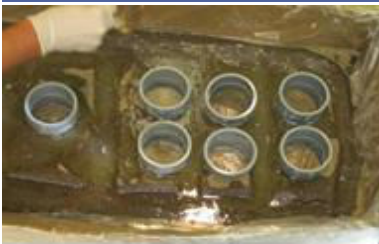
InstaGrout-Material verteilen mit einem Rührstab
