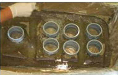
InstaGrout mit einem Rührstab verteilen
