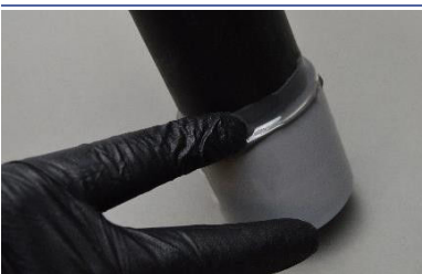
BonDuit auf der Kupplung glätten
