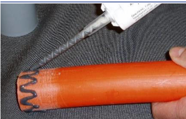
BonDuit Klebstoff auftragen
