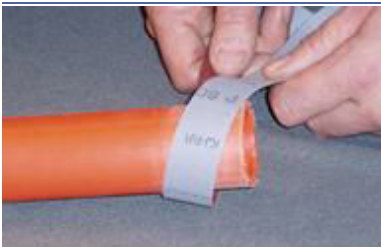
Rohr und Kupplung schleifen
