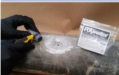
Spachtelmasse schneiden
