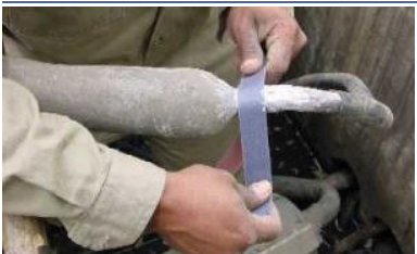
Kabel für die Reparatur schleifen
