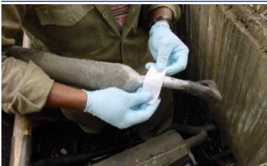
Kabel mit Reinigungstuch säubern
