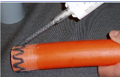
Apply BonDuit Adhesive
