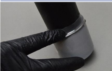
Smoothing BonDuit on coupling
