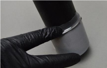
Smoothing BonDuit on coupling
