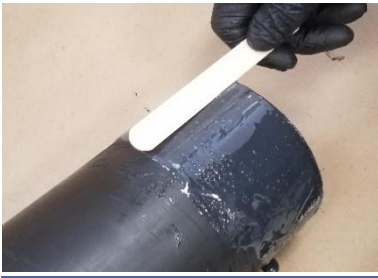
Spreading BonDuit on Conduit
