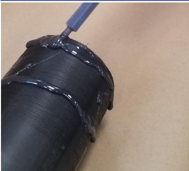
Apply BonDuit Adhesive
